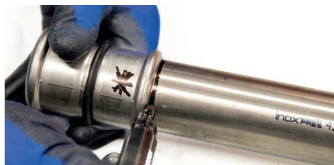
Obrázek 32 – Označení hloubky zasunutí s použitím tvarovky
