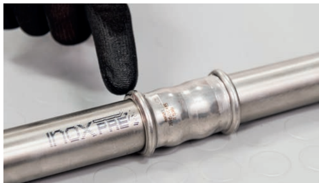
Obrázek 38 – Kontrola lisovaného spoje
