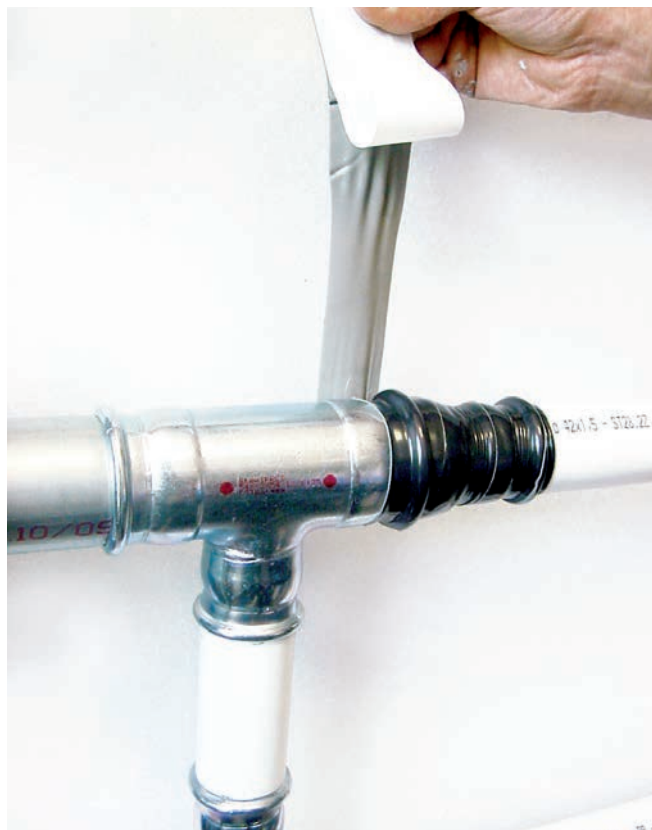
Obrázek 43 – Ochrana spojů butanolovou lepicí páskou
