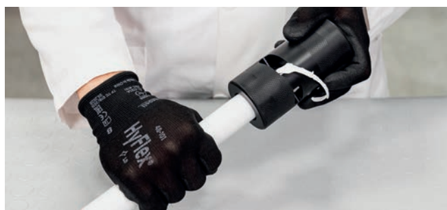
Obrázek 31 – Odstranění pláště (steelPRES s PP pláštěm)
