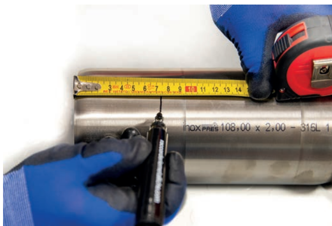
Obrázek 28 – Označení hloubky zasunutí s použitím svinovacího metru
