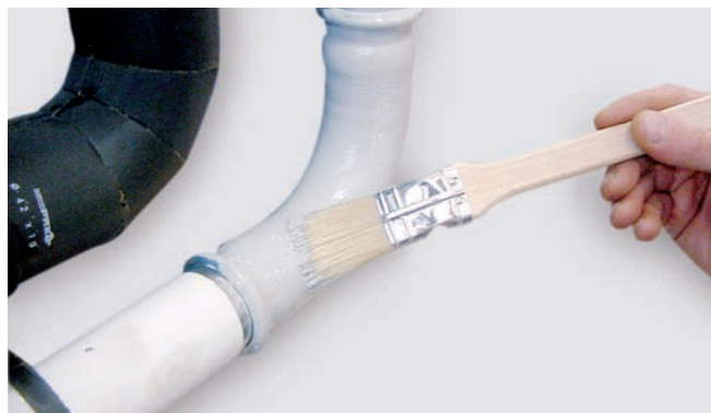
Obrázek 42 – Lakování přípojek a trubek základním nátěrem.
