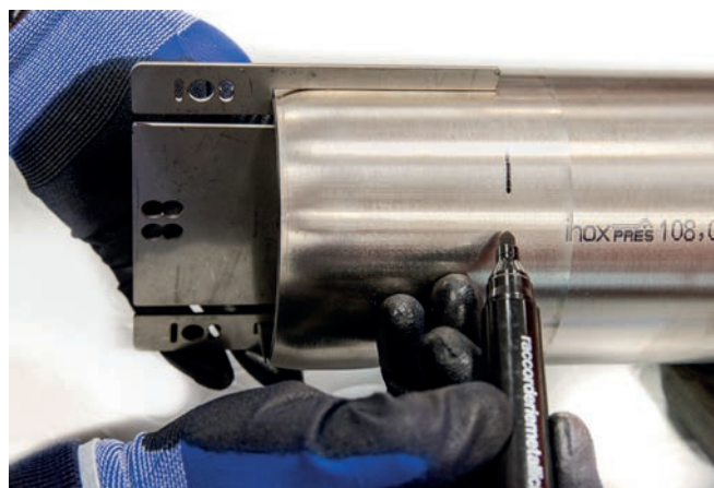
Obrázek 29 – Označení hloubky zasunutí s použitím popisovače Ø 76 mm – Ø 88 mm – Ø 108 mm
